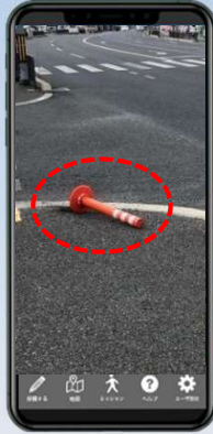
ポストコーンの 損傷
