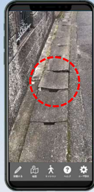
溝蓋の 損傷
