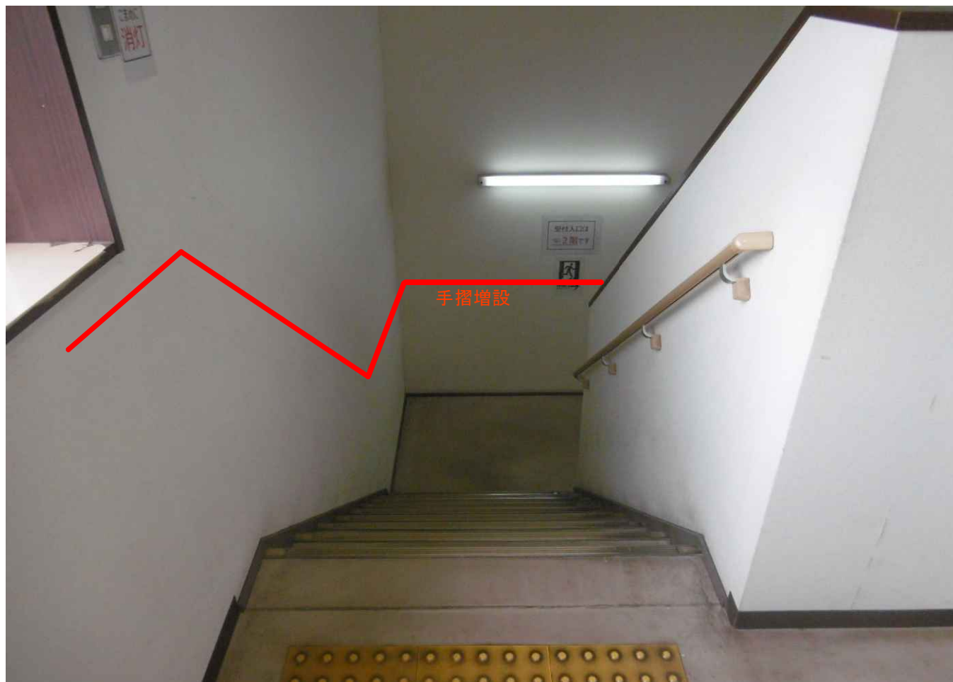
2階廊下より見下し
