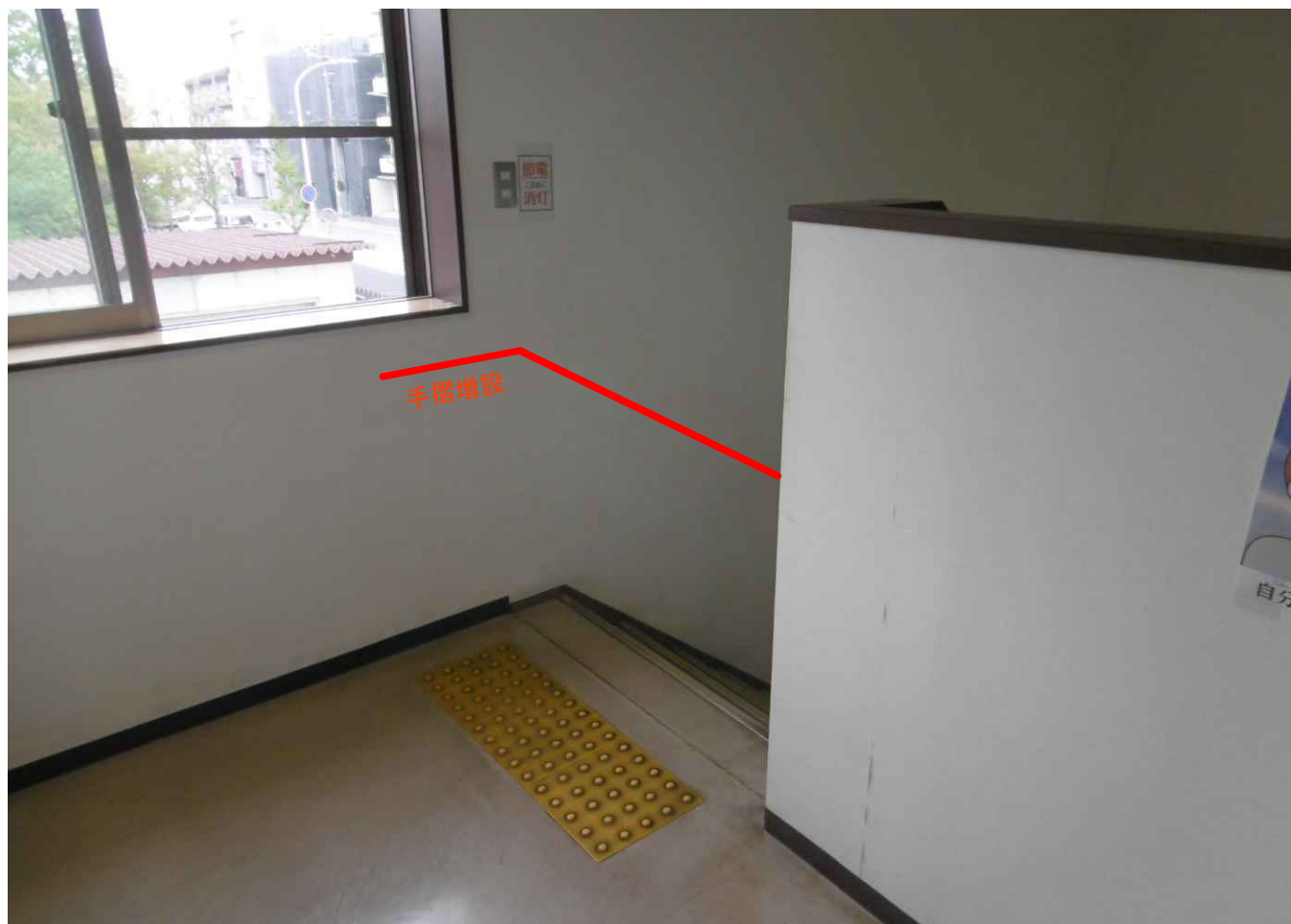
2階廊下より階段へ
