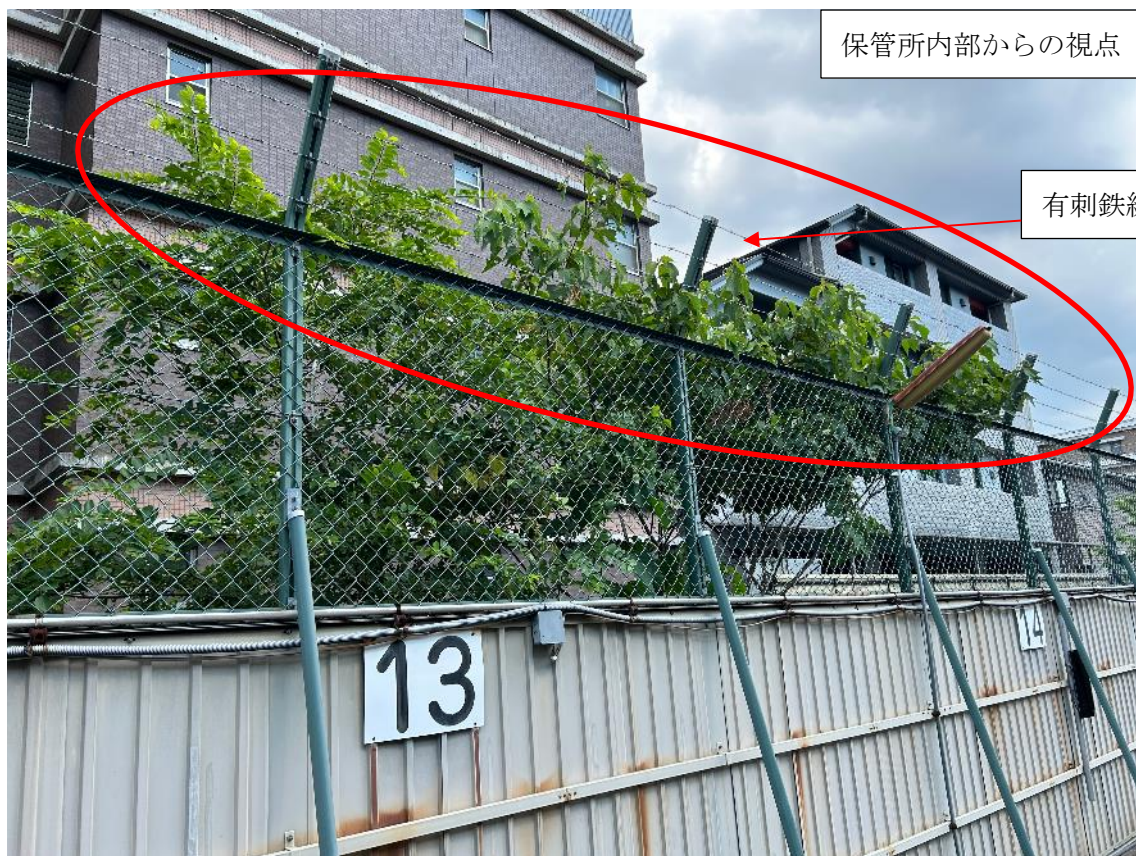
保管所東側（写真）
