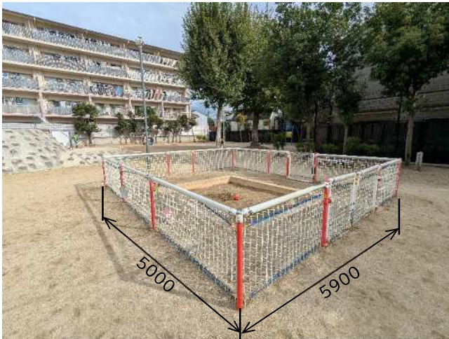
(修繕対象 全景)
