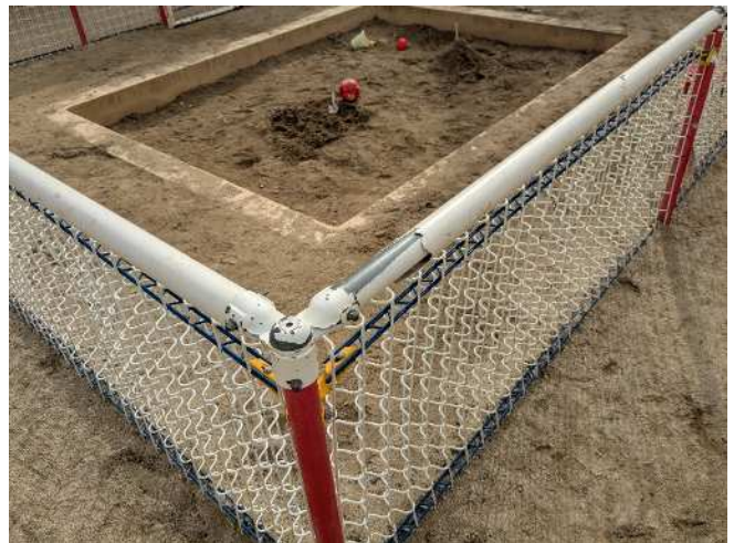
(破損部 近景(一部))
