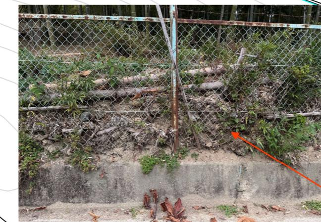
一部背面に土砂が堆積（最大H=約1.0m）
