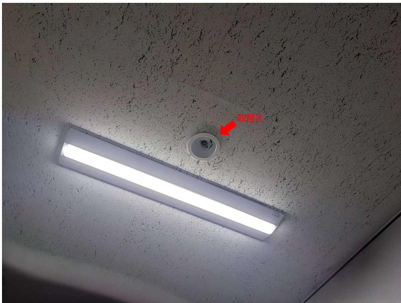
写真6（非常照明器具）※取付状況は2台とも同じ
