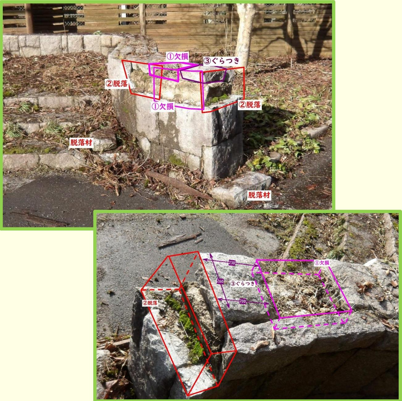
「A」「B」とも上記写真位置の修繕が対象となる。既存仕様の御影石の材料厚は約10cmであり、欠損部分はこれを参考にして新材を用意する。なお、基盤となる部分のモルタルが浮きなどの脆弱な状態となっている場合があるため、これらは確実に取り除いたうえで、石張りを施すこと。
