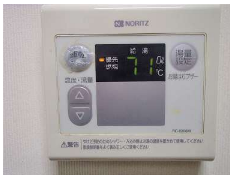
リモコンスイッチ (RC-6206M) / エラーコード 71
