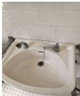
◇屋外トイレ男子手洗い蛇口①
