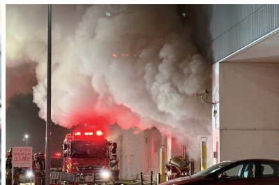
南部クリーンセンター火災被害状況
