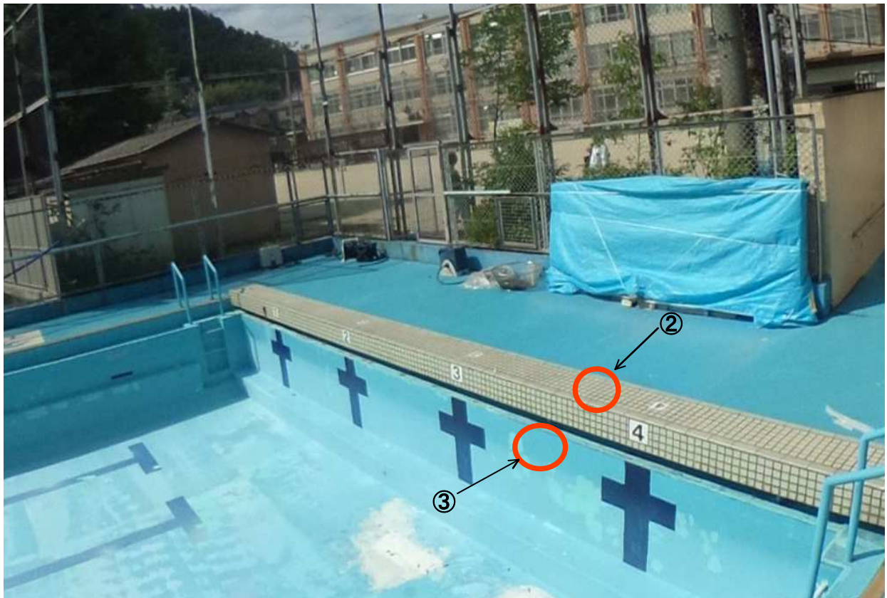
② プール水槽タイル部分の下地モルタル ③ プール水槽側面の色モルタル
