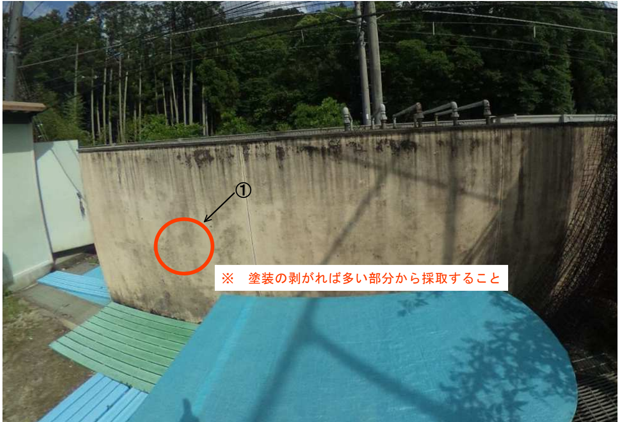
① 洗体施設側壁（グラウンド側）の塗装下地
