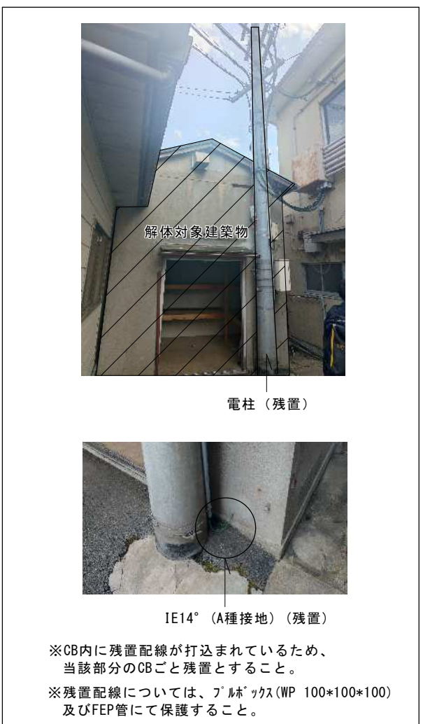
解体対象建築物写真
