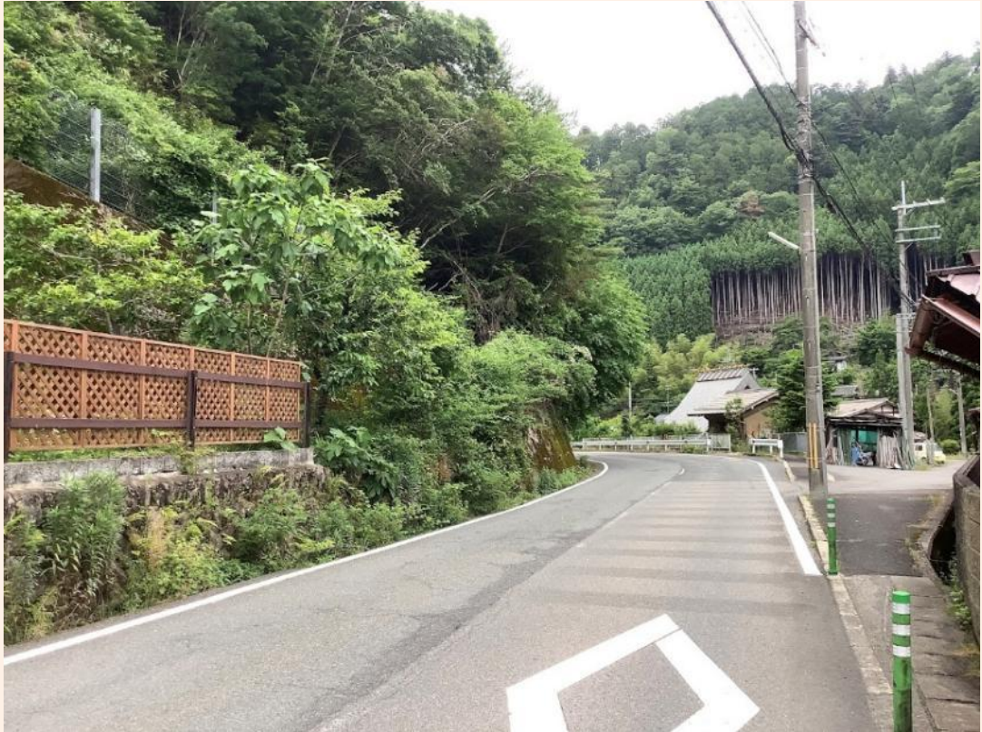
写真①（起点側）
