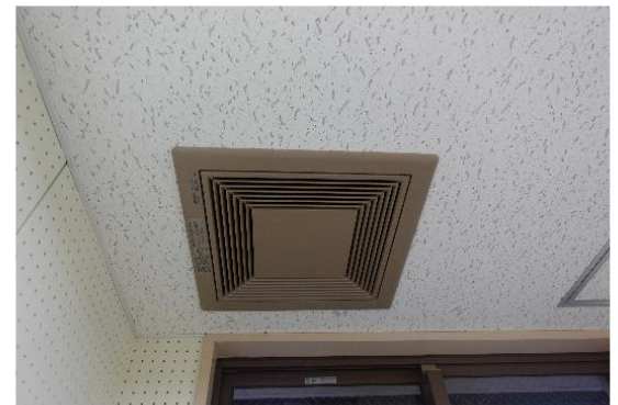
換気扇箇所拡大
