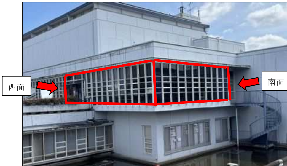
外部から見た対象箇所 その1（参考写真）
