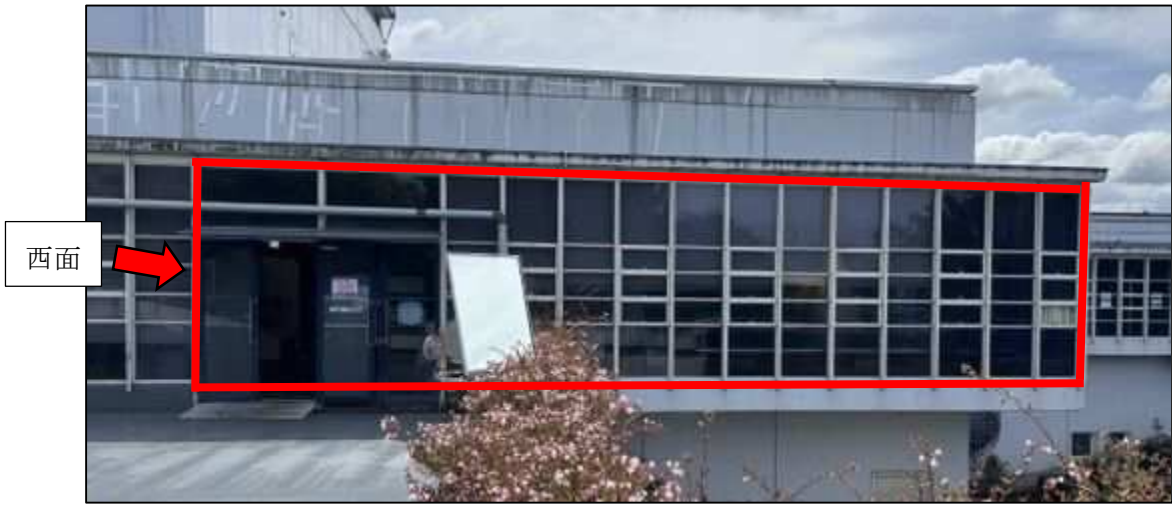
外部から見た対象箇所 その2 (参考写真)
