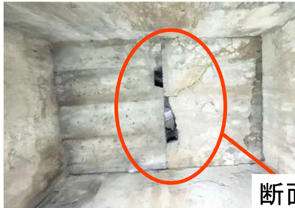
コンクリート版下面（破損状況）
