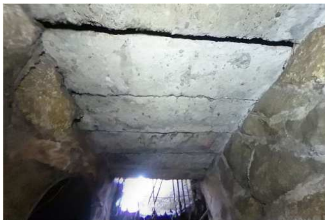
道路桁6本状況
