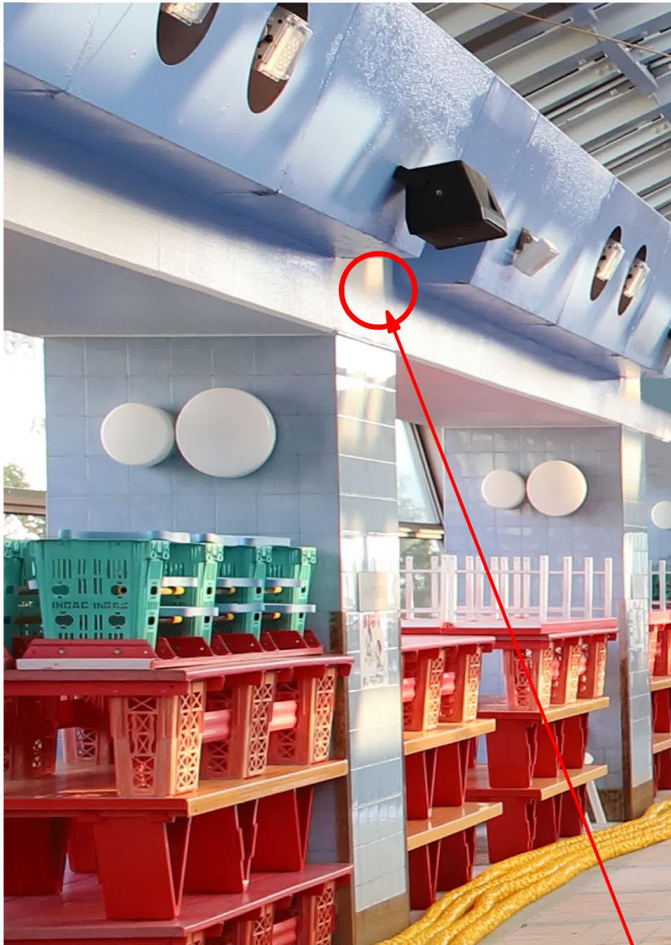
屋根梁の腐食度調査 測定部位（可動屋根受梁）
