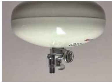
自動消火装置
