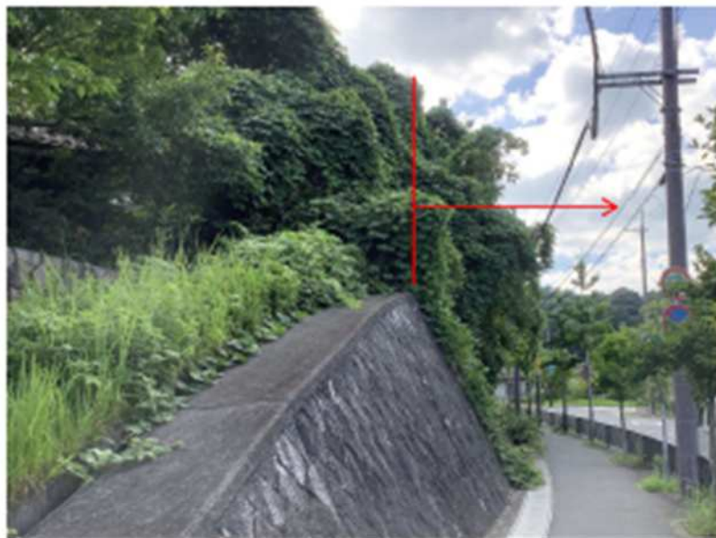
石積み天端より道路側にはみ出した樹木枝を撤去し除草
