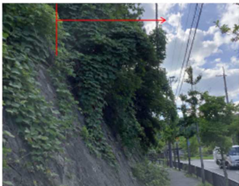
石積み天端より道路側にはみ出した樹木枝を撤去し除草
