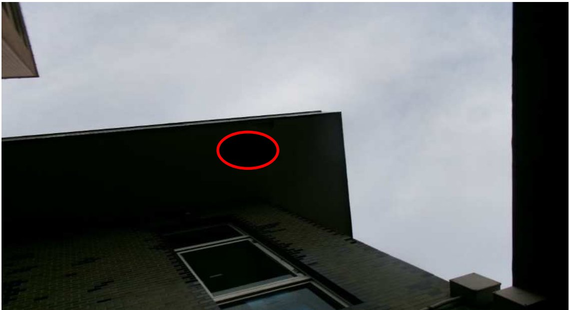
業務範囲（修繕箇所）事務所西面
