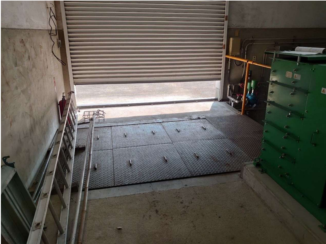
③ 縞鋼板の状況
