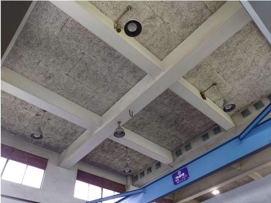
①天井（天井照明の設置状況）
