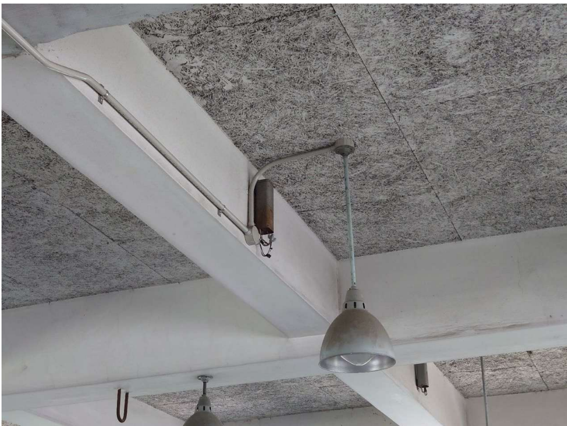
②安定器の設置状況
