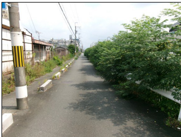
②伏見区竹田向代町川町 地内（南行き）
