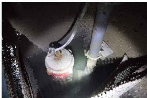
写真 3：ストレーナーネット内
