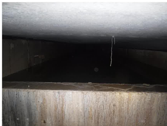
写真 9：路面排水槽現状
