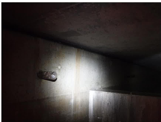
写真 10：通気管 SGP50A（電線配管として利用）
