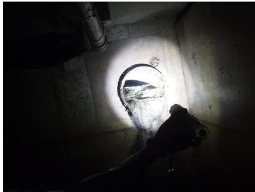
写真7：道路排水集水管内部
