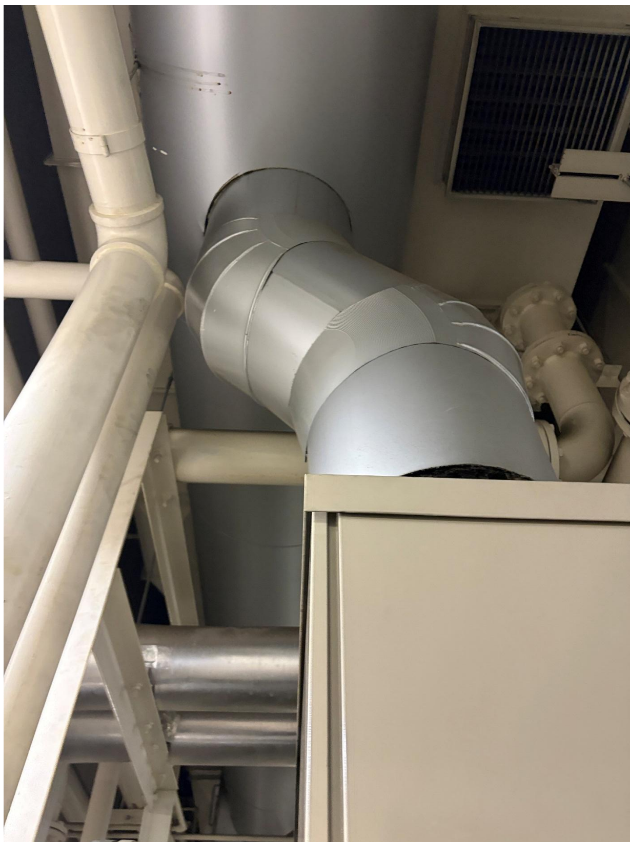
参考 2-1_煙道断熱材 煙道
