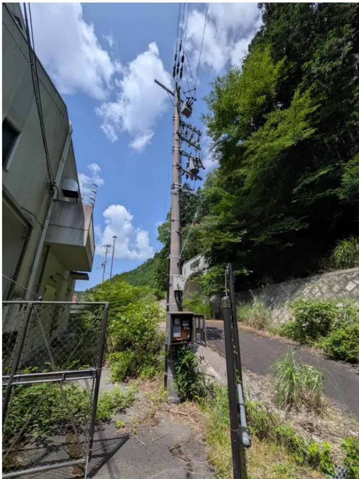
【構内柱全景東側より】
