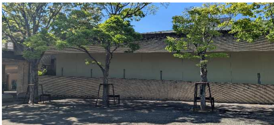
傾斜路（スロープ）の外観
