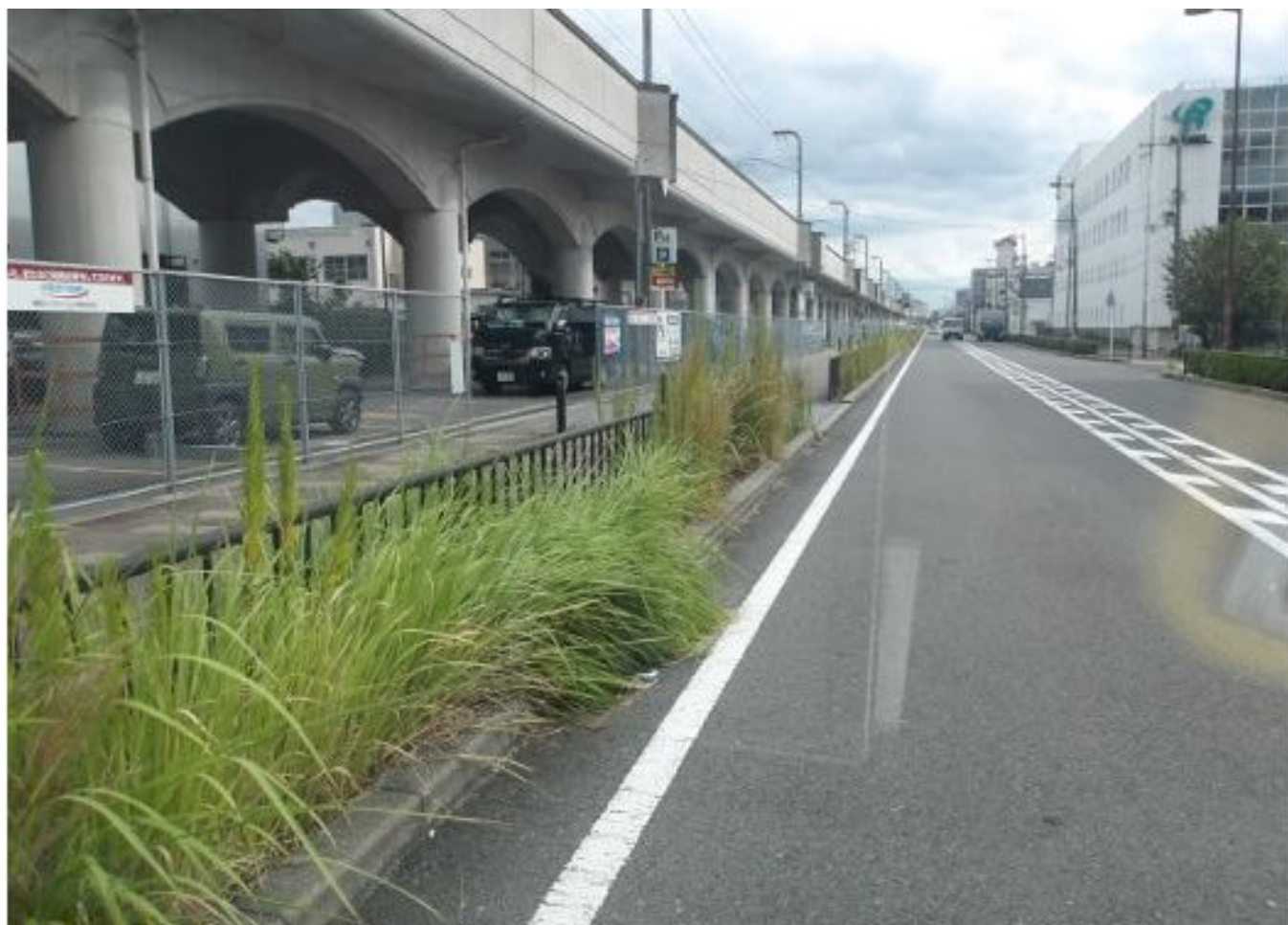
現況写真①
