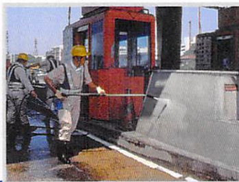
▲ コンクリート壁の汚れ落とし
