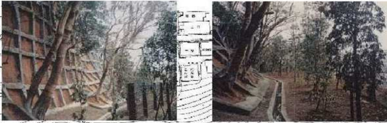
現場打水路L=50m
