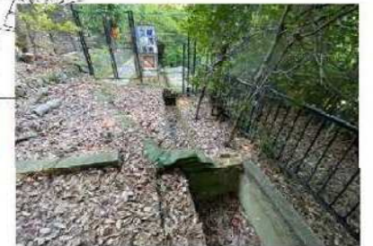
コンクリート水路 L=約45m
