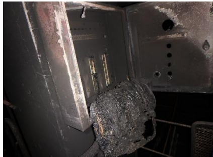
東北部クリーンセンター (平成 31 年 3 月)
