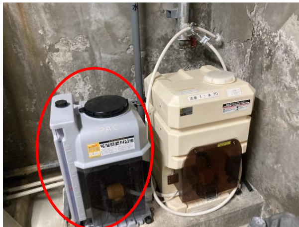
(参考) 撤去前の写真
