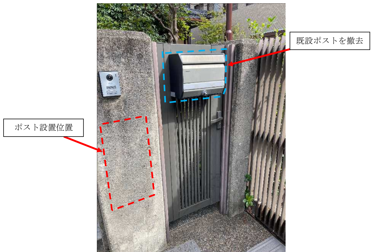
◎設置箇所（写真）
