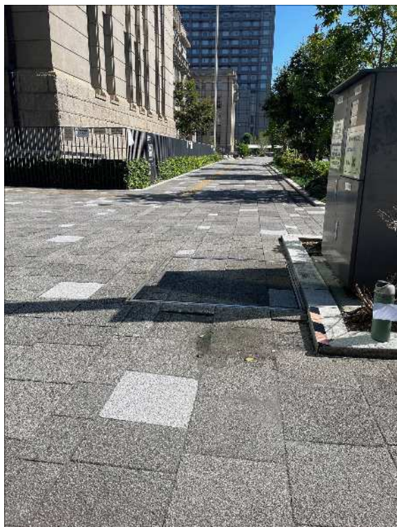
◎修繕箇所（全景）
