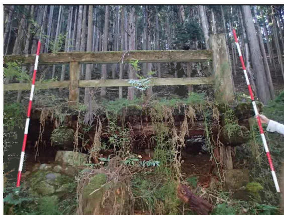
木道側面(河川側より撮影)
