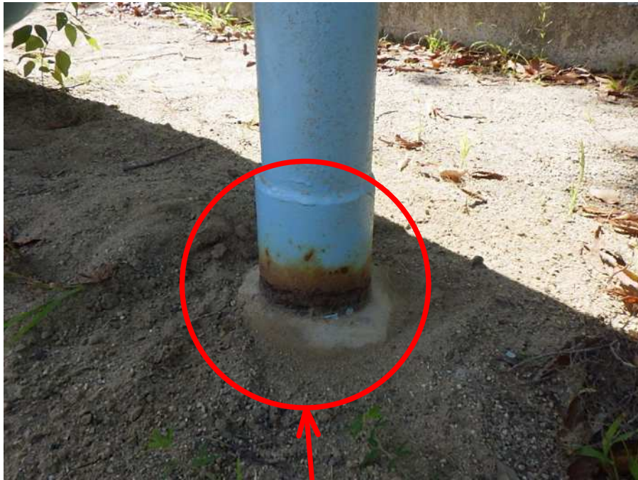
③すべり台の支柱 地際部の腐食
