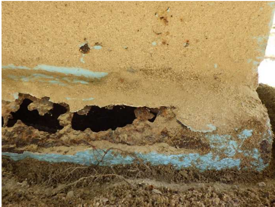
②すべり台の滑り降りた箇所 鋼管の腐食が著しい。
