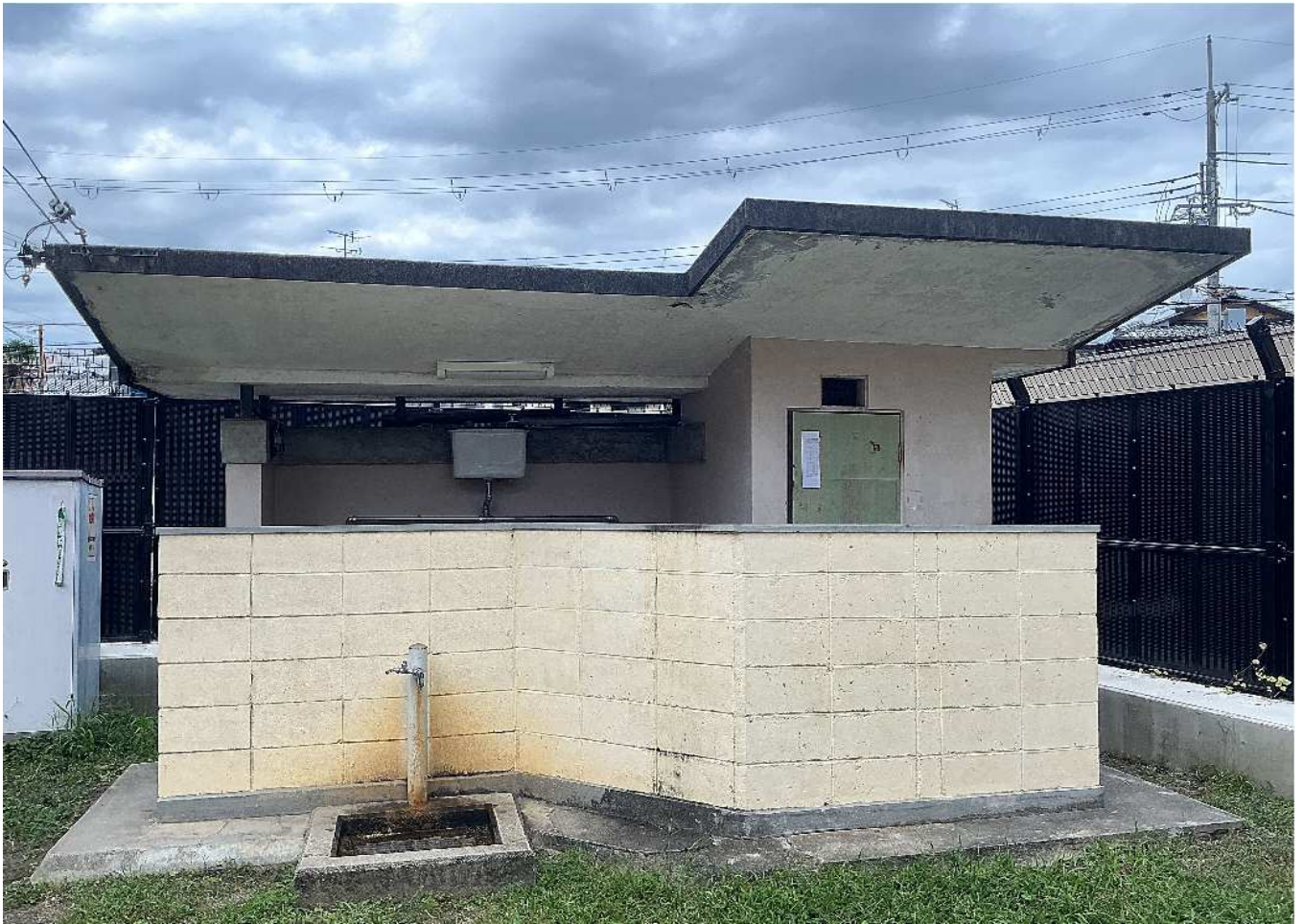
泉殿公園トイレ
