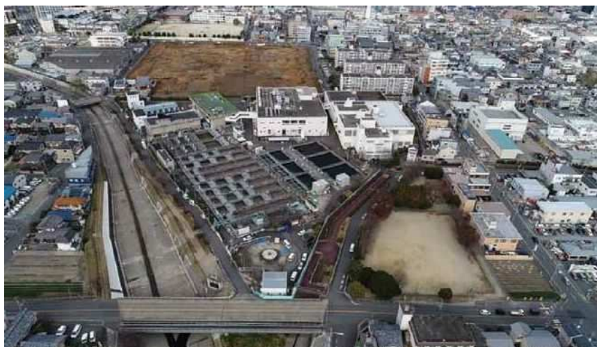
吉祥院支所全景
