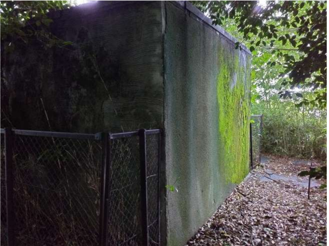
【参考】京都市左京区修学院南代町 地内
