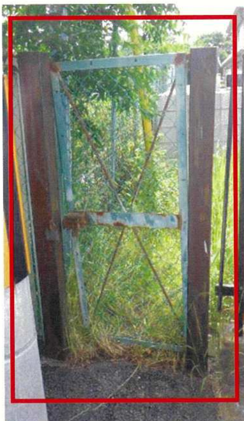
ネットフェンス用方開門扉 (H1450×W600) ※既設支柱に傾き有、丁番にて調整が必要
