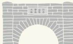
第二トンネル東口 Second tunnel East entrance
